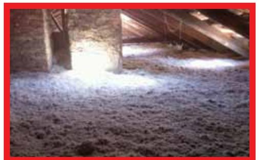
Grazie al sistema d'insufflaggio si ottiene una distribuzione omogenea dello strato isolante qualunque sia la forma dell'intercapedine, garantendo così un isolamento al 100%.
